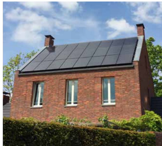
Voldak systeem geeft meestal een rustig beeld.
