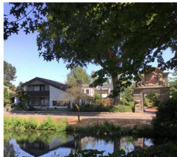
Ligging in 1e orde zone, maar niet karakteristiek qua architectuur; Maatwerk is vereist, maar op het grote donkere dakvlak zijn zonnepanelen voorstelbaar, die de beschermde waarden niet aantasten
