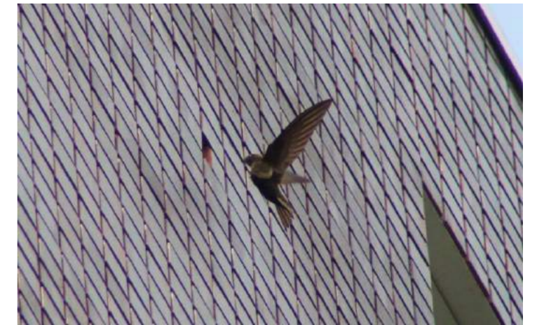
Gierzwaluwsteen weggewerkt in gevel
