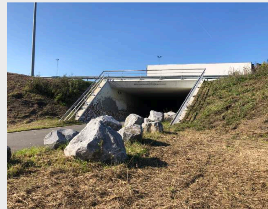
Voorbeeld van een faunapassage in een onderdoorgang
